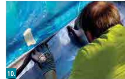
10. Botament® PB Portaldichtband mit Fixierstreifen am Fensterelement anbringen.
