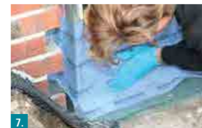
4. Botament® RD 2 mit einem Quast oder Pinsel auftragen und Formteile, hier Außenecken, einsetzen.
