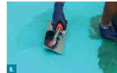
8. Zweite Abdichtungsschicht aus Botament® RD 1 | RD 2 in gleicher Arbeitsweise auf der getrockneten ersten Lage aufbringen.
