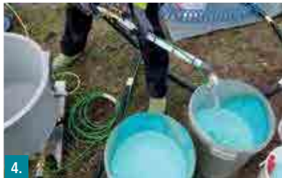
4. Förderpumpe, Mörtelschlauch und Spritzkopf mit reichlich sauberem Wasser spülen.
