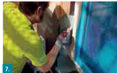
7. Botament® BD Butyldichtband vollflächig mit Botament® RD 2 überarbeiten.
