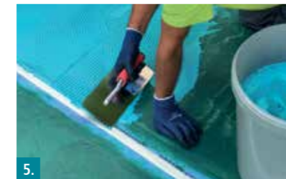
5. Erste Abdichtungslage aus Botament® RD 1 | RD 2 mit einem Zahnglätter auftragen.
