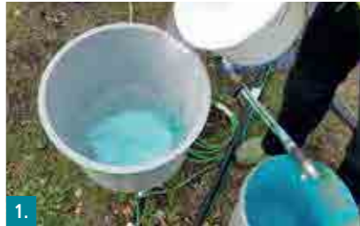
1. Nach Fertigstellen der Arbeiten restliches Material aus Materialbehälter und Schlauch herauspumpen. Materialbehälter mit Wasser füllen.
