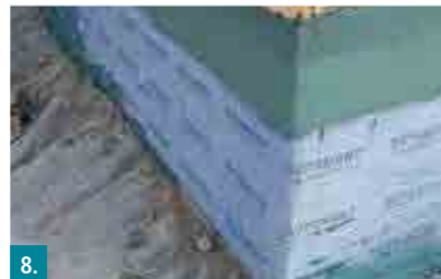
8. Enden und Übergänge des Portaldichtbands mit Botament® RD 2 überarbeiten.
