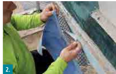
2. Klebestreifen an der Rückseite des Portaldichtbands abziehen.
