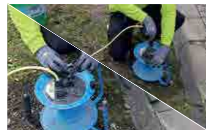
8. Düse mit 5 mm Durchmesser am Spritzkopf anbringen.
