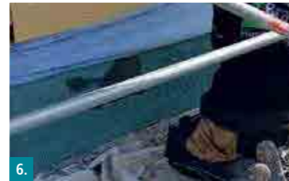
6. Auf der durchgetrockneten Kratzspachtelung vollflächig Botament® RD 2 mit einem Zahnglätter aufziehen.
