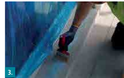
3. Staub und Schleifrückstände entfernen.
