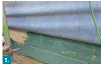
5. Betonflächen vornässen. Kratzspachtelung auf Beton- und Holzflächen aufbringen. Überschüssiges Material wieder entfernen.
