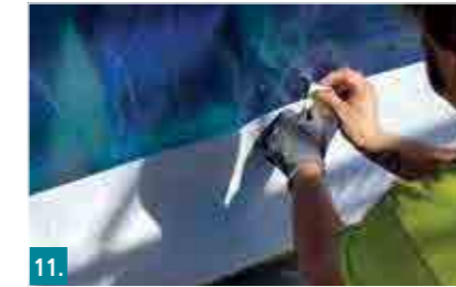
11. Botament® PB Portaldichtband mit Klebeband provisorisch am Fenster fixieren.
