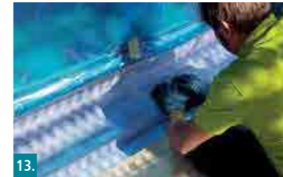
13. Botament® PB Portaldichtband faltenfrei in die frische Abdichtung einbetten.
