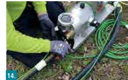
14. Mörtelschlauch abbauen.
