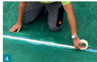
4. Dehnzonen in den Dichtbändern mit Klebeband abdecken.
