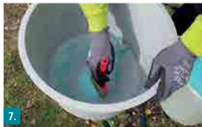
7. Mörtelbehälter mit geeignetem Werkzeug reinigen.
