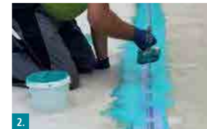
2. Fugen und Ecken mit Botament® SB 78 Systemdichtband und Botament® PB Portaldichtband abdichten.
