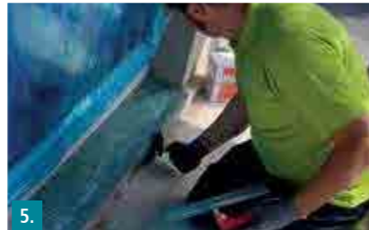
5. Kratzspachtelung aus Botament® RD 2 auftragen.
