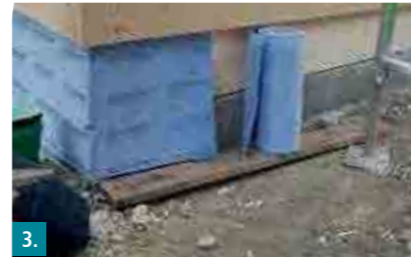
3. Portaldichtband 15 cm über Geländeoberkante fixieren.
