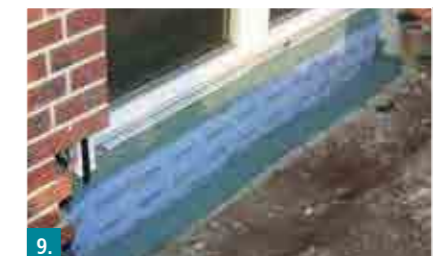
6. Untergrund mit Botament® RD 2 (Auftrag mit Pinsel, Quast oder Zahnglätter)
