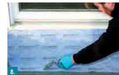
5. Zugeschnittenes Portaldichtband mit dem Klebestreifen am Fensterrahmen fixieren.
