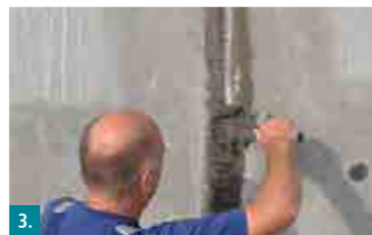
3. Fugen mit Botament® M 36 Speed verschließen.
