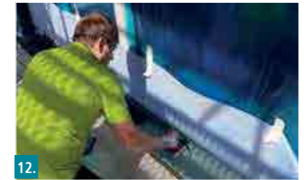
12. Untergrund vollflächig mit Botament® RD 2 versehen.
