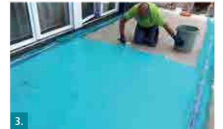
3. Untergrund mattfeucht vornässen und Kratzspachtelung mit Botament® RD 1 | RD 2 herstellen.
