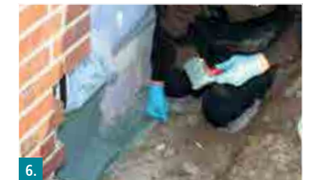
3. Botament® RD 2 mit einem Quast oder Pinsel auftragen und Formteile (hier Innenecken) einsetzen.
