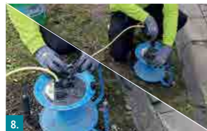
8. Kompressor und Förderpumpe vom Strom trennen.
