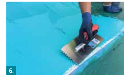
6. Zahnstege im frischen Zustand glätten ohne Material zu entfernen.
