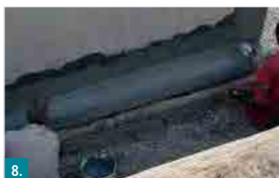
8. Auf der durchgetrockneten Kratzspachtelung Botament® RD 1 | RD 2 auftragen. Botament® GS 98 Glasseidengeewebe in die erste Abdichtungslage einbetten. Auf der Bodenplatte die Abdichtung mindestens 10 cm auf der Stirnseite herabführen.
