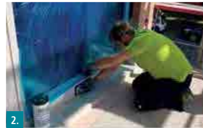
2. Fensterelemente mit Gitterschleifer oder Schleifpapier anrauen.
