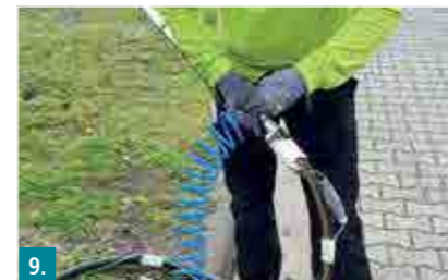
9. Luftschlauch demontieren.
