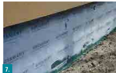
7. Portaldichtband faltenfrei einbetten.
