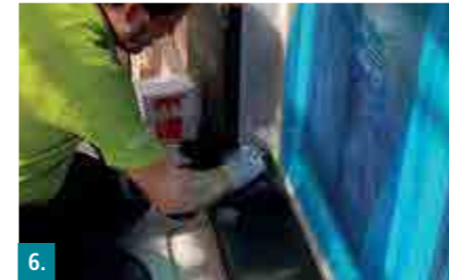
6. Übergänge von der Leibung zum Fensterelement ggf. mit Botament® BD Butyldichtband abdichten.
