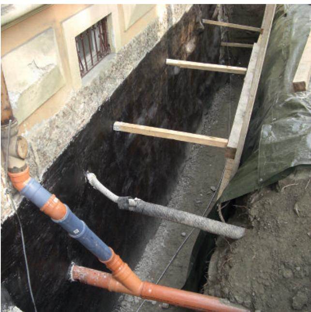
Reaktivabdichtung PCI Barraseal® Turbo auf Altabdichtungen
